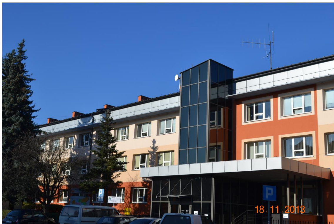
Fot.1. Budynek Starostwa Powiatowego w Dąbrowie Tarnowskiej
